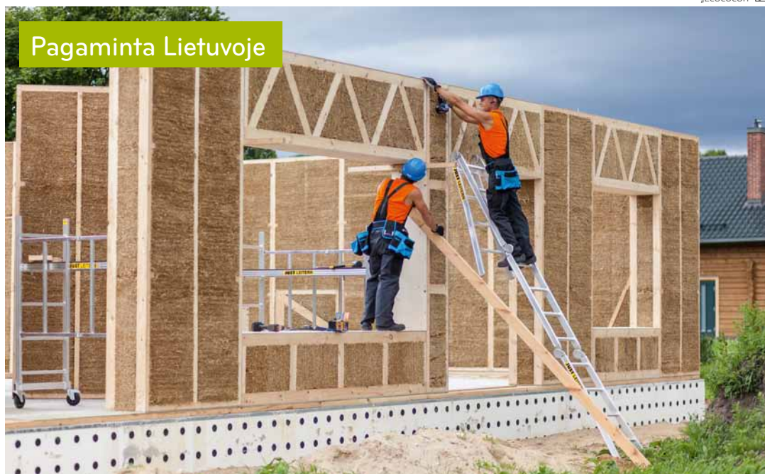
➤ Šiaudiniams skydams montuoti nereikia kranų ir kitos sunkiosios technikos
