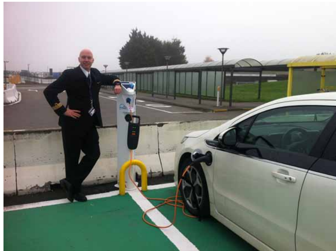
► Oro uosto personalui įrengtos dvi elektromobilių įkrovimo stotelės
